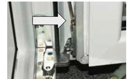
Anheben und Absenken des Flügels mit Inbusschlüssel SW4, bei Schwerlastbeschlag mit Torx T25.
