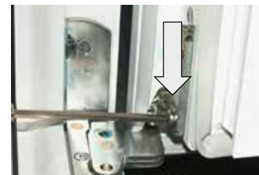
Anpressdruckverstellung mit Inbusschlüssel SW4.
