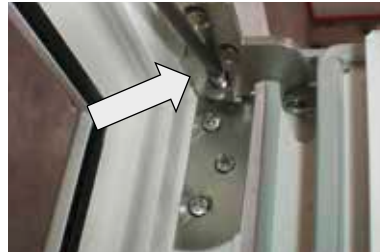
Verstellung bei Schwerlastbeschlag mit Torx T25.
