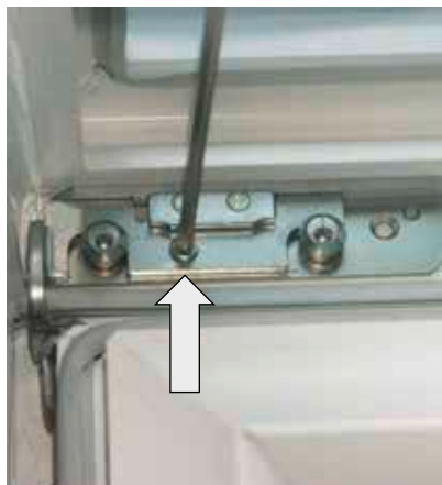
Fixierschraube am Kipplager mit Inbusschlüssel SW4 lösen.
