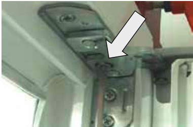
Verstellung Richtung Band- oder Ge- triebeseite mit Inbusschlüssel SW4.
