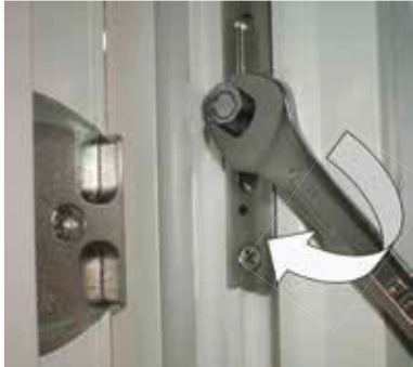
Gewünschten Anpressdruck mit Gabelschlüssel SW11 einstellen. Die Verstellung ist in Schritten von 22,5° möglich.
