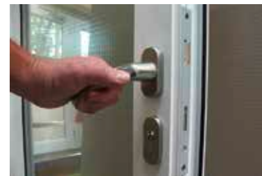
Öffnen der Tür - Drücker (aus dem unversperrten Zustand)
