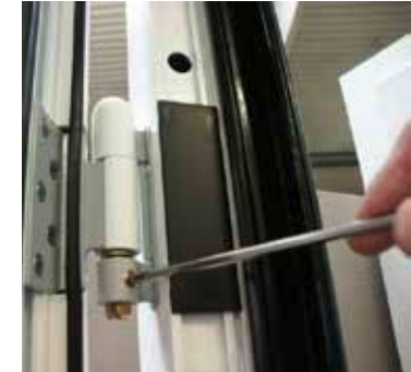
Fixierschraube lösen.
