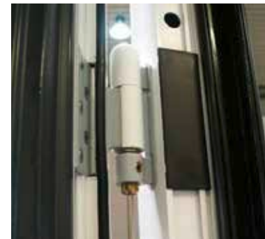
Höhenteller durch Drehung nach rechts bzw. links in gewünschte Position bringen.
